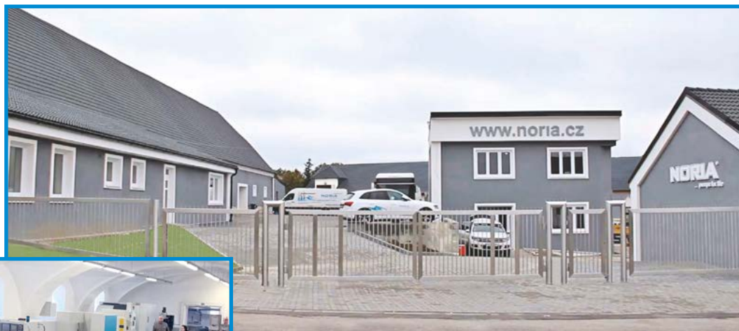
Výrobní areál společnosti NORIA v Tavíkovicích
